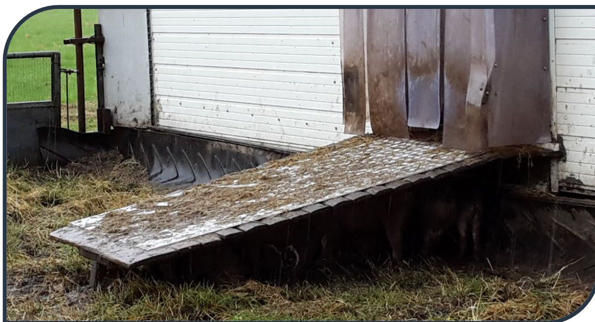
Rampe beklædt med riflet aluminiumsplade ved indgangen til smågrisevognen (Foto: Rikke Thomsen)
